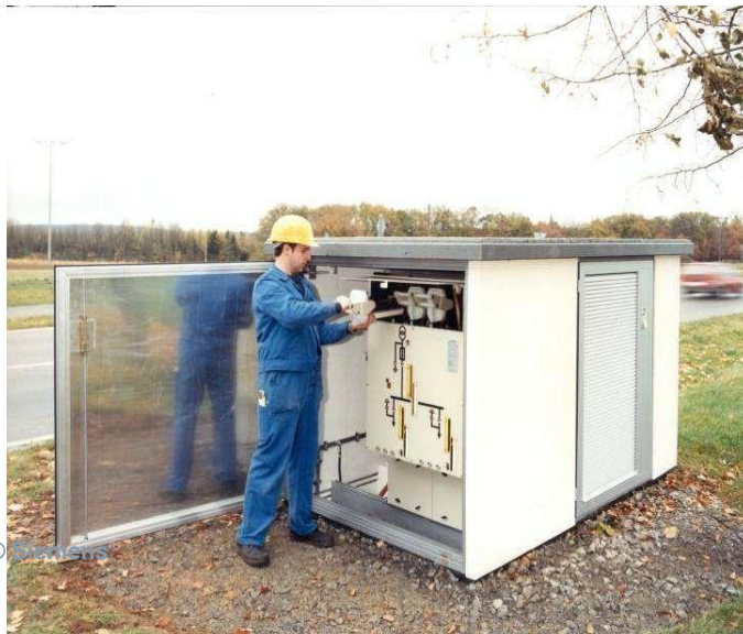
IAC-A (substation doors open)
